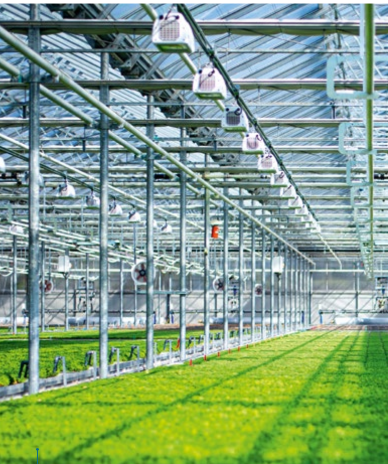
Med kontrollsystemet helioCORE och dimningsbara armaturer kompletteras dagsljuset som strömmar in genom växthusets väggar och tak automatiskt med rätt mängd elljus.
